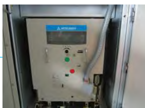
■ Вакуумный выключатель
